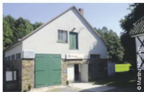
Das Firmengebäude der Schreinerei in Mühlen.
