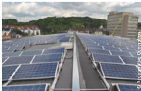
Im Bau: Anlage auf der Schwalbe-Arena.
