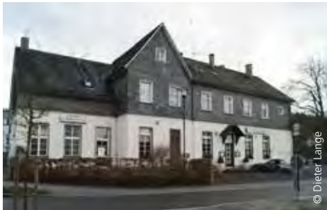
Der unter Denkmalschutz stehende Wiehler Bahnhof wird umgebaut und enthält sieben Apartments.
