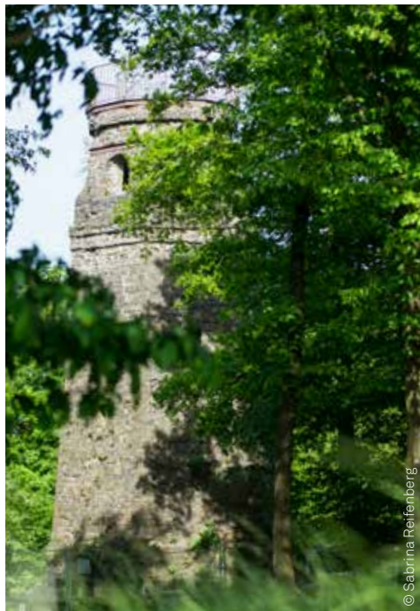
Wiehler Bismarckturm: Sanierung oder Abriss?
