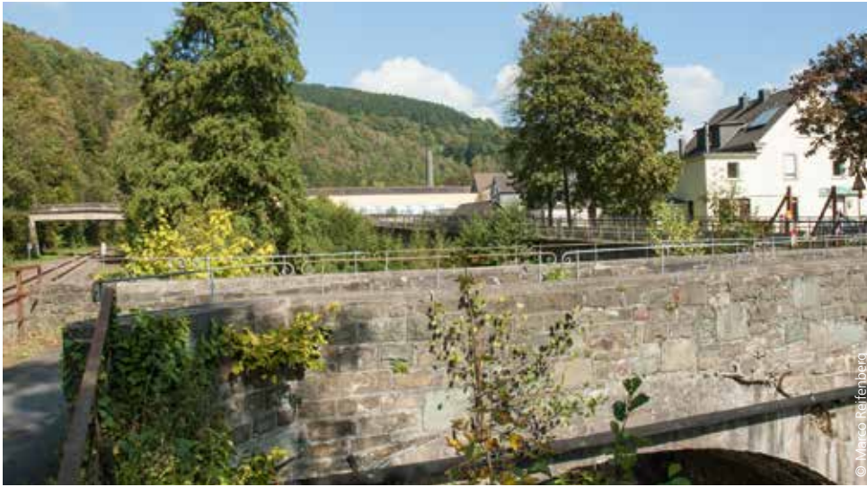
Die Bingenhof-Brücke in Osberghausen soll nun im kommenden Frühjahr endlich saniert werden.
