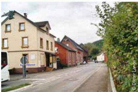
Die Rospetalstraße zwischen der heutigen B 55 und der Westtangente wird 2015 saniert und rund ein dreiviertel Jahr für den Durchgangsverkehr gesperrt.
