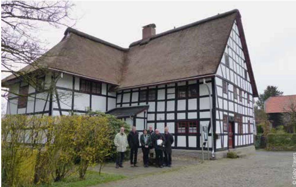
Die aufwändige Sanierung der alten Fuhrmannsherberge „Weißes Pferdchen“ in Hohkeppel ist abgeschlossen.
